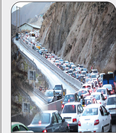
لرزم اعتماد سازی در جامعه تاکید کرد و ادامه داد: در سیل دی مساه پل توکل آباد در ریگان در حال فروریختن بود اما هر چه ما به مردم می‌گفتیم که پل در حال ریزش است، توجیهی به خطراتهای ما نمی‌کردند تا با ورود شورای تأمین و نیروی انتظامی توانستیم جلوی تردد از روی این پل را بگیریم و کمتر از پنج دقیقه بعد پل ریزش کرد و این مهم نشان دهنده عدم اعتماد مردم است. مدیرکل راهداری و حمل و نقل جاده‌ای استان کرمان درباره پیش‌فروش بلیط‌ها سخن به میان آورد و تصریح کرد: پیش‌فروش بلیط از دهم اسفند به صورت اینترنتی آغاز شده و ۵۰ درصد ظرفیت به این صورت به فروش می‌رسد و مابقی ظرفیت به صورت حضوری فروخته می‌شود.
